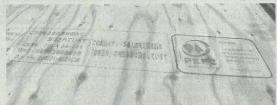
森林認証のスタンプが押されたコンクリート型枠用合板＝東京都東村山市の東村山福祉園改築工事現場
